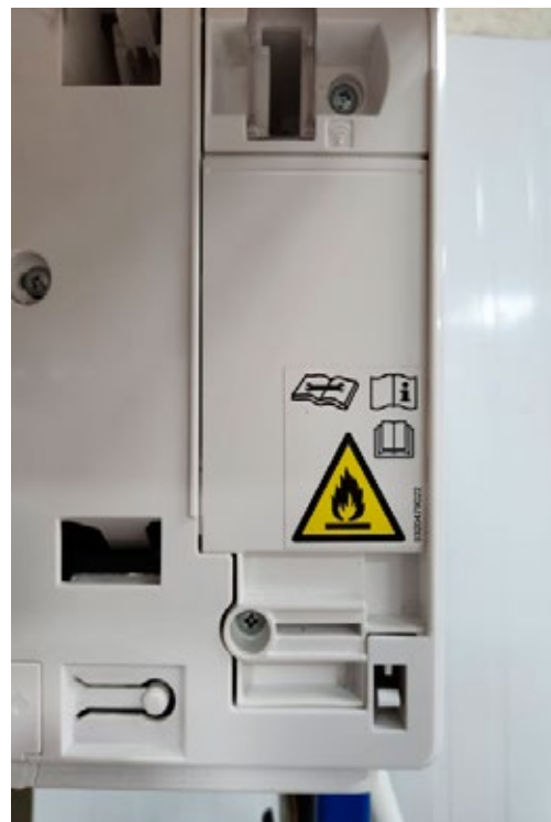
Indicación Inflamabilidad Ubicada en la Unidad Interior
