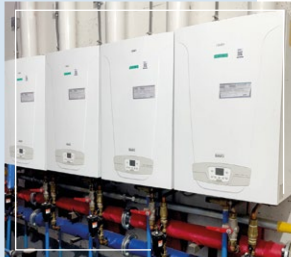
CALDERAS DE CONDENSACIÓN
